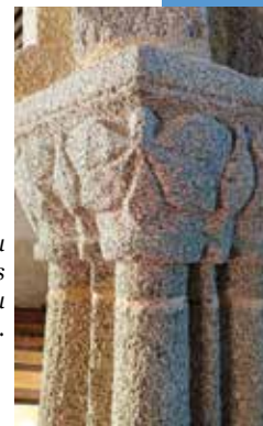
◇ Pile avec faisceau de huit colonnettes ornées d'un chapiteau avec décor végétal.
