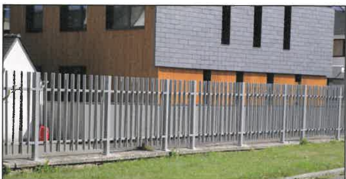
Sécurisation par une rambarde autour de la salle polyvalente
